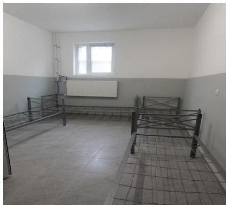
Спално помещение в ремонтния корпус
