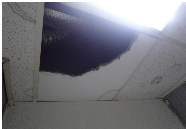
Част от видимите щети по окачения таван на първия етаж на Арест Пловдив
