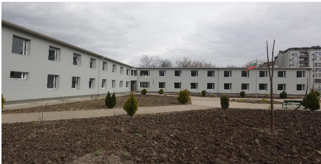
ЗООТ „Хеброс“ /корпус/
